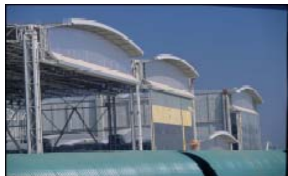
Hall de montage de l'Air bus A380 - Toulouse
